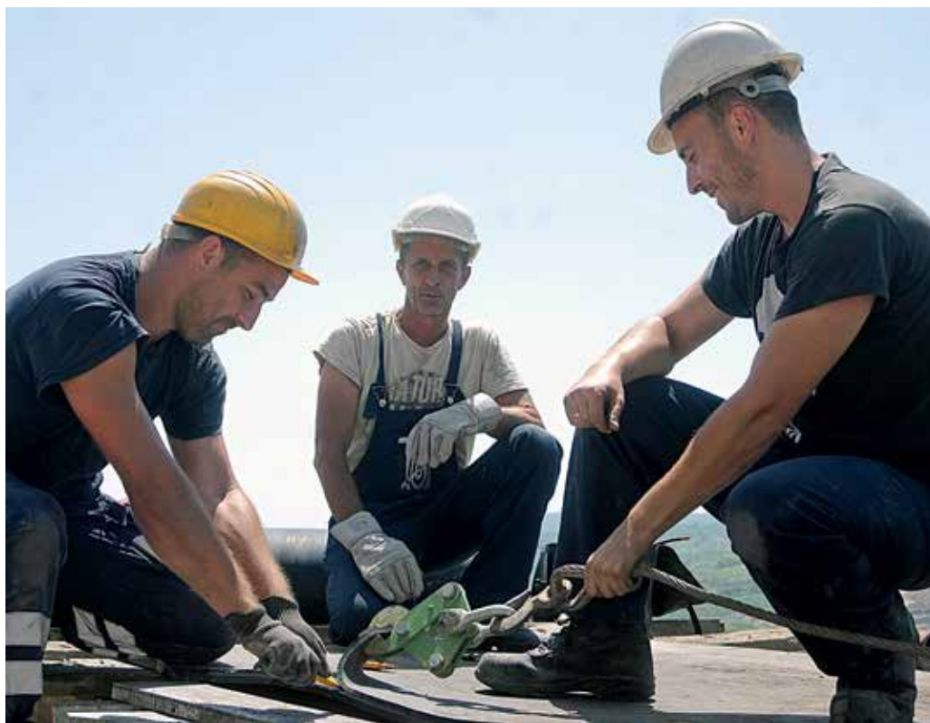
■ Вулканизери током израде споја
