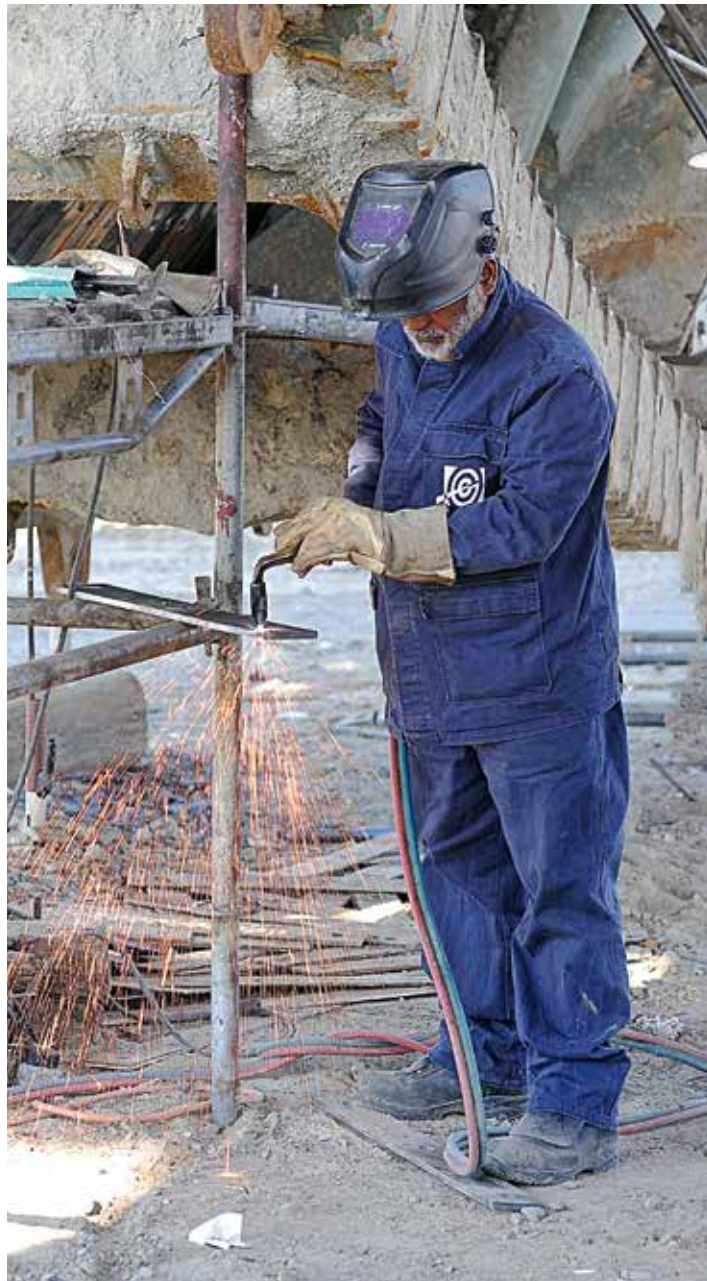
■ Ремонтни радови на „глодару 3“
