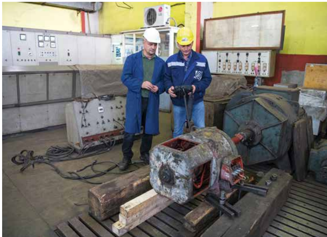
■ Мерење електромотора вибродијагностиком
