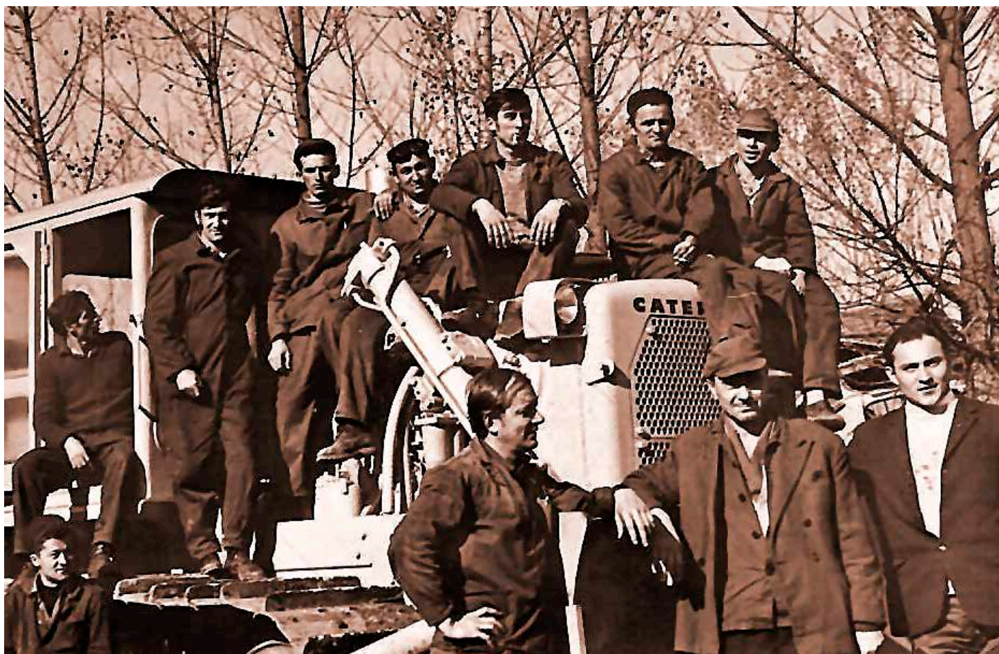
Детали из историје „Помоћне механизације“
