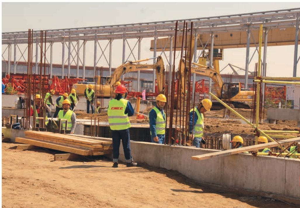
■ Градилиште новог блока
