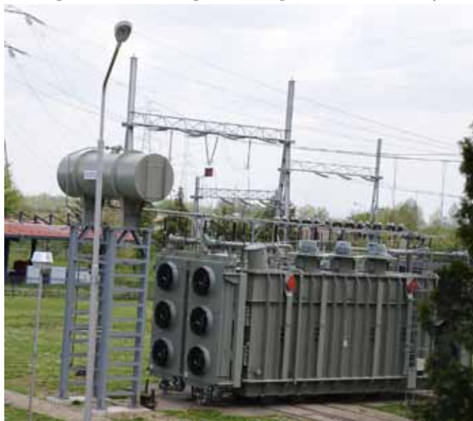
Нови блок трансформатор је припремљен за монтажу
