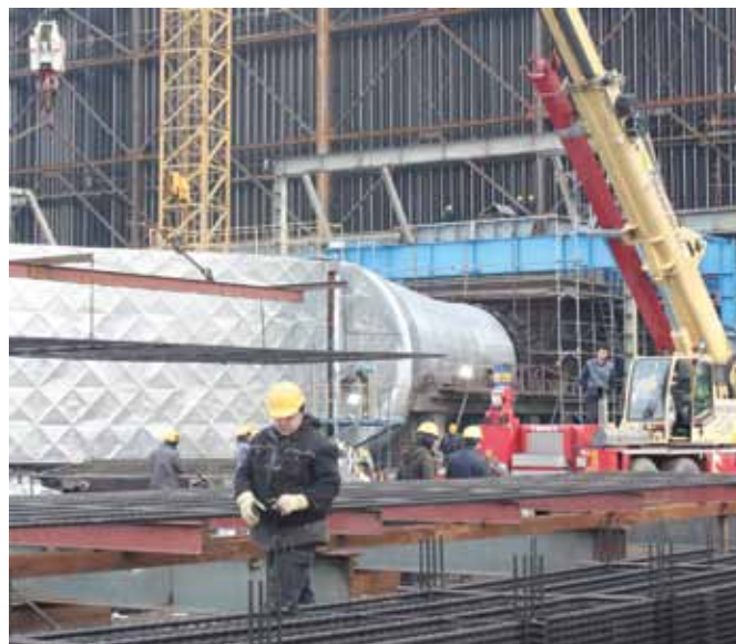
Електрофилтер у завршној фази на блоку ТЕНТ А-3 (архивски снимак)
