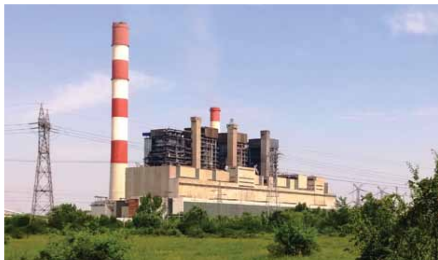
Ремонтна сезона у ТЕНТ А је почела 1. маја
