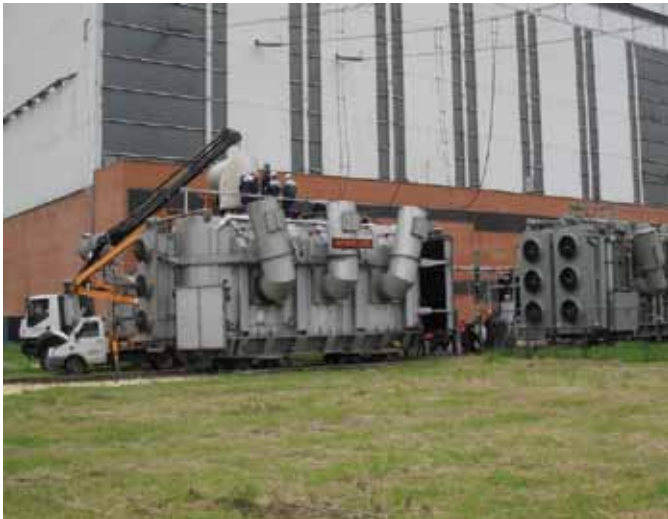
Замена старог трансформатора новим
