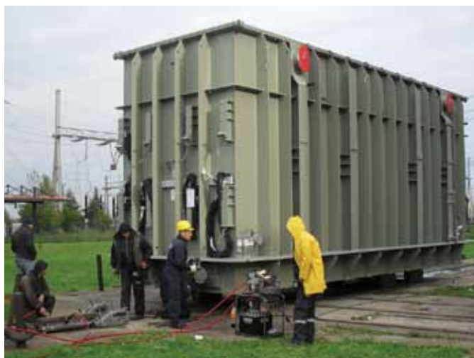
Монтажу трансформатора су обавили запослени фирме „Електроисток изградња“
