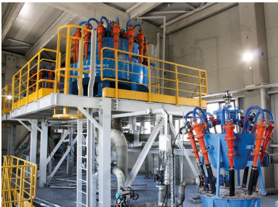
■ Унутрашњост објекта Ц-100
