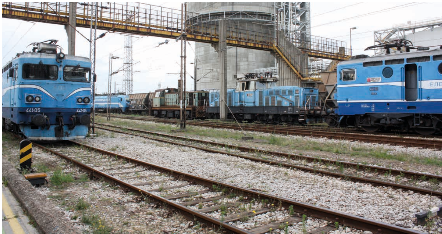
■ Ремонти возила и пруге завршени квалитетно и у предвиђеним роковима
