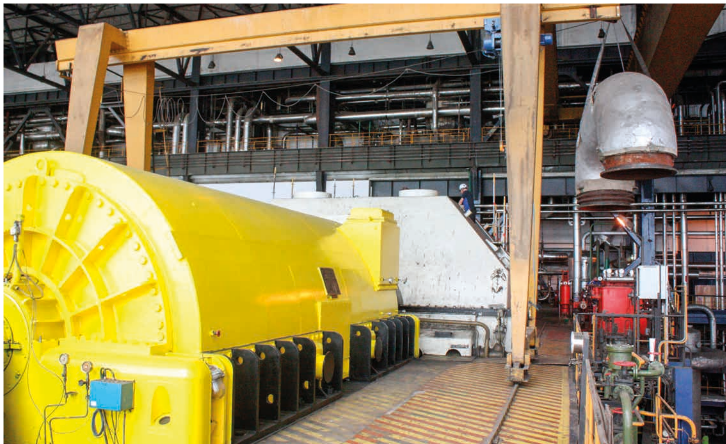
■ Турбоагрегат А1 у ремонту
