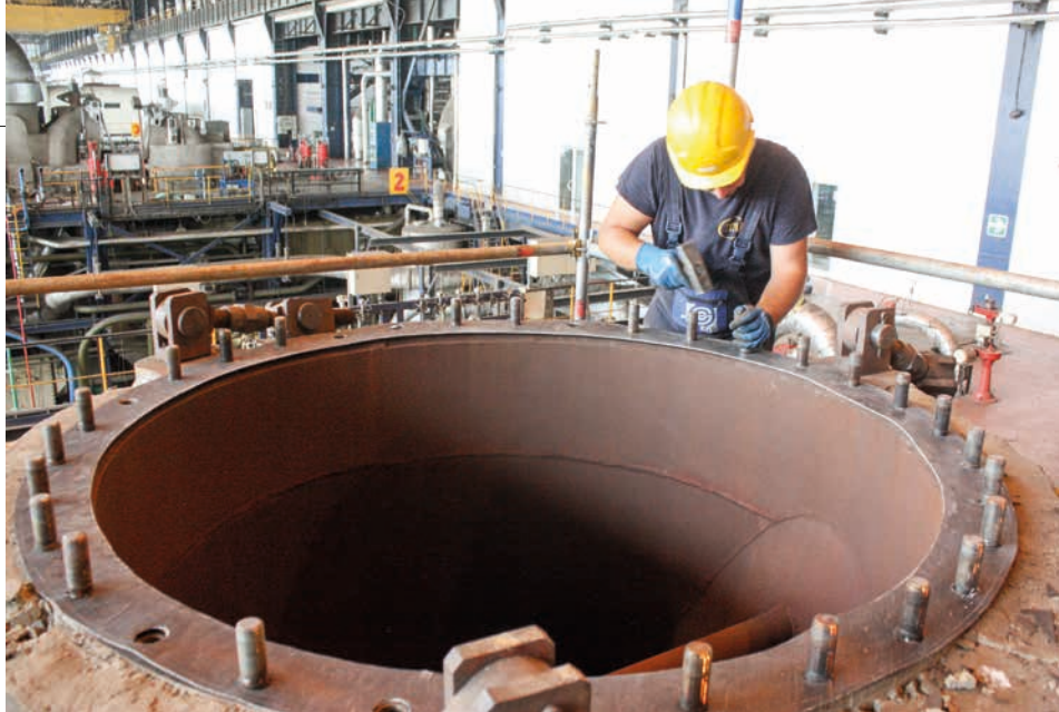
■ Припрема за постављање заптивки
