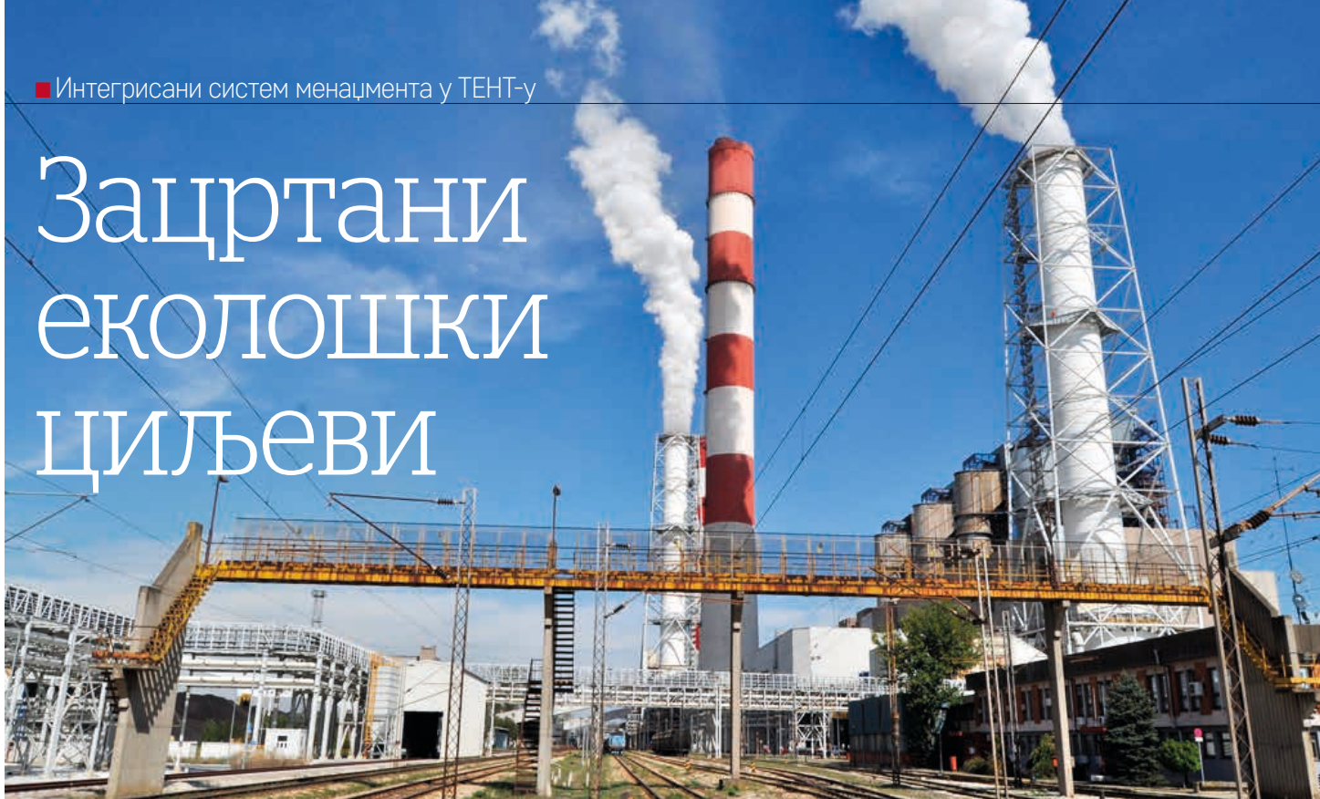
■ ОДГ постројење на локацији ТЕНТ А
