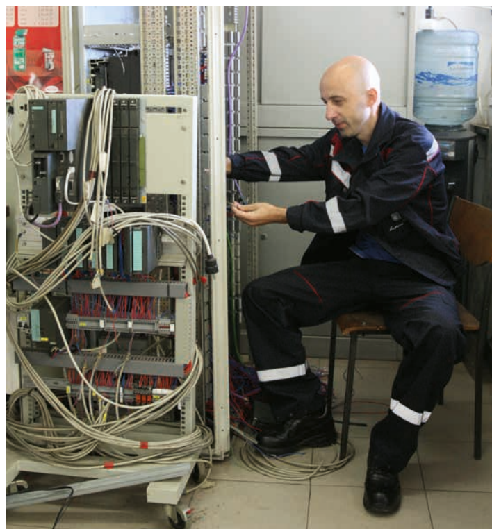
■ Реконструкција старог ормара за управљање
