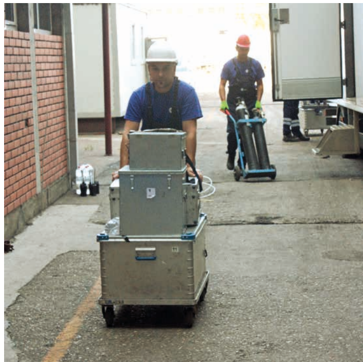
■ Опрема се монтира на коти 0 метара
