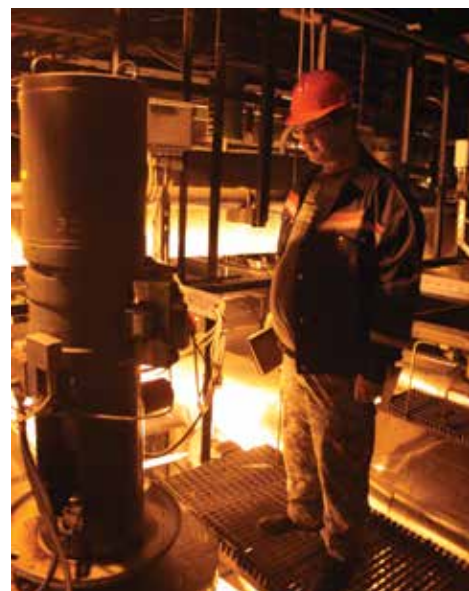
■ Регулациони вентили BY PASS високог притиска
