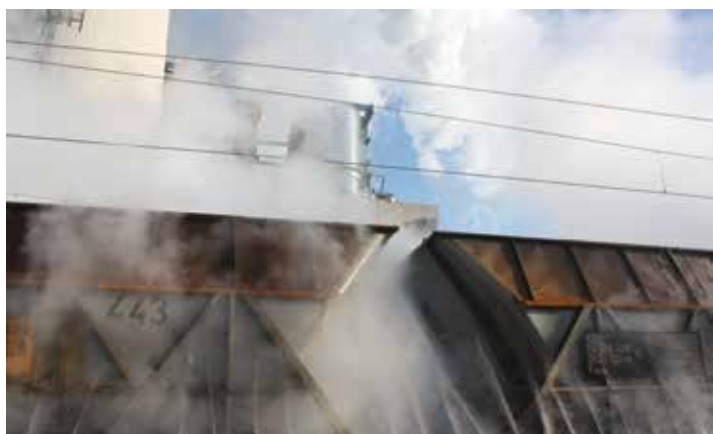
■ Систем за одмрзавање у ТЕНТ А после ревитализације, знатно ефикаснији
