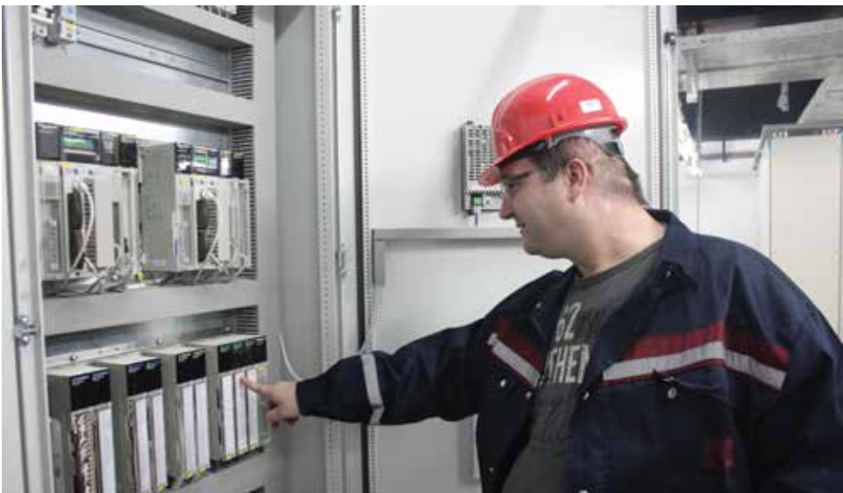
■ Управљачки орман BY PASS- а високог притиска
