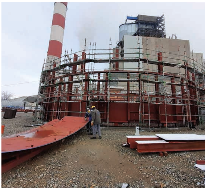
■ Апсорбер за блокове 5 и 6 - монтажа челичне конструкције Фото СКИП
