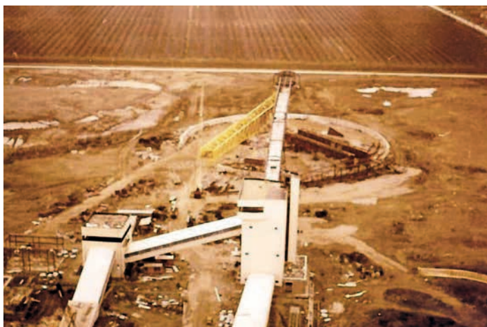
■ Монтирање опреме на депонији угља ТЕНТ Б 1983. године
