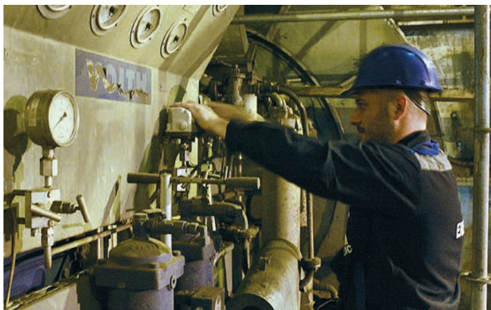
■ Електричарски радови на млиновима блока А6
