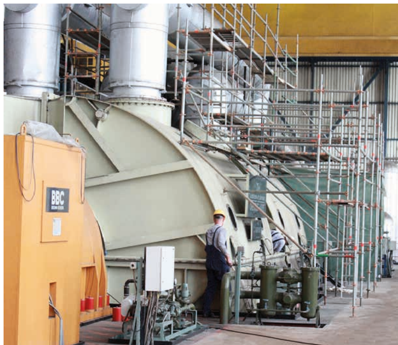
■ Припремни радови за капитални ремонт Б1
