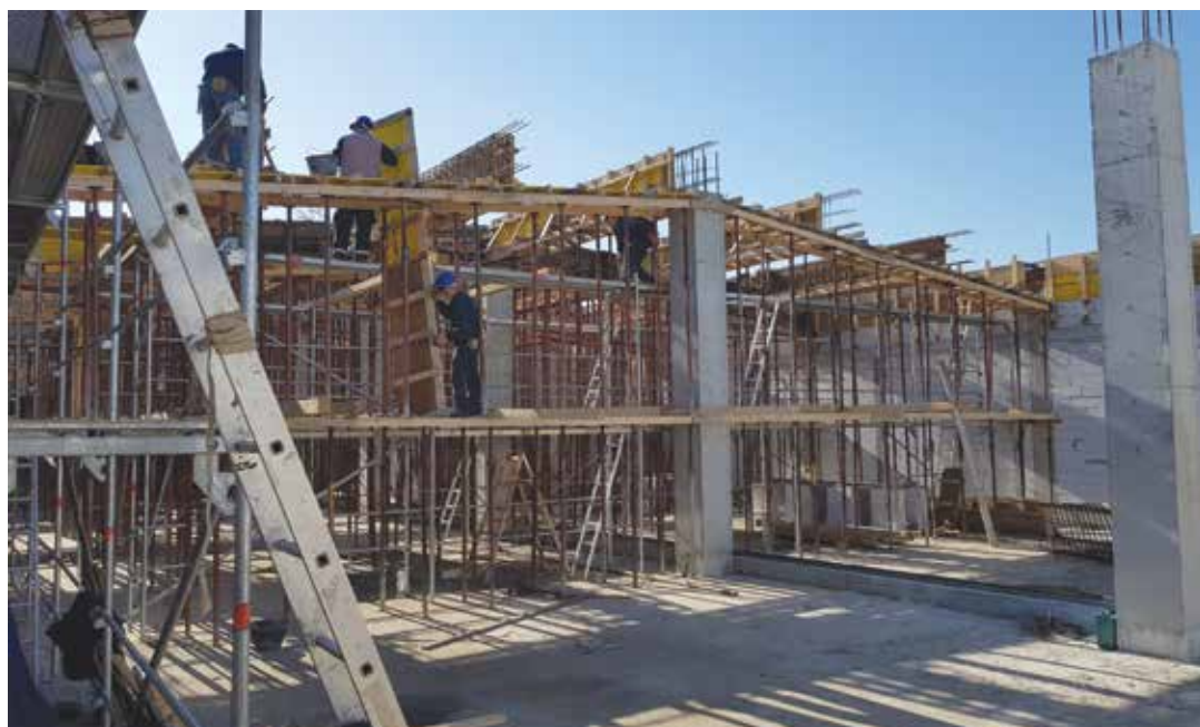
■ Складиште уља и мазива у изградњи
