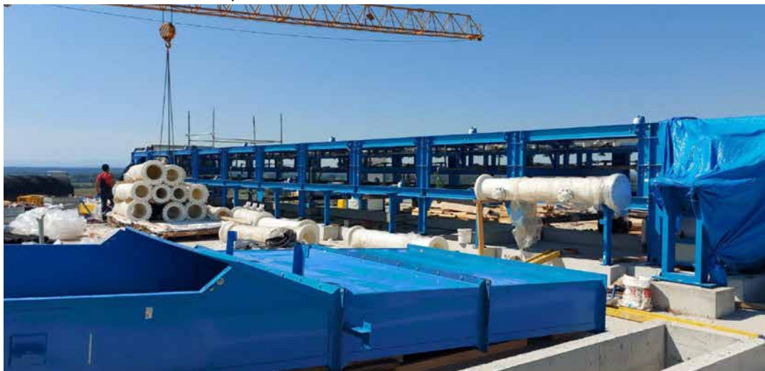
■ Силос гипса - монтажа машинске опреме
