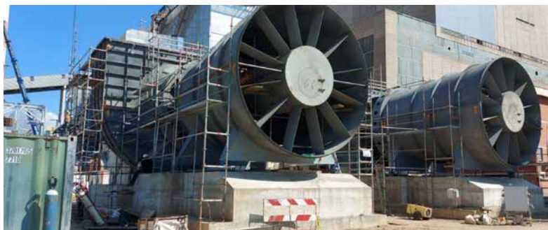
■ Монтажа вентилатора
