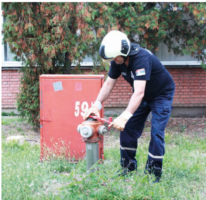
■ Провера исправности хидранта
