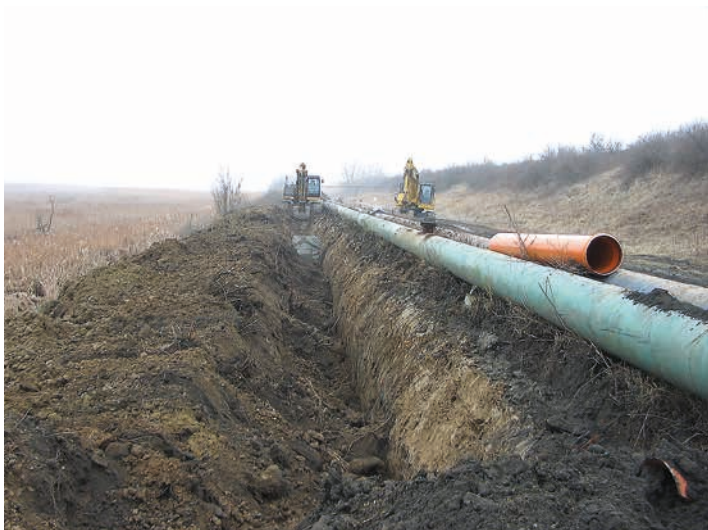
■ Радови на изградњи трећег дренажног прстена на касети 2 депоније пепела и шљаке ТЕНТ Б
