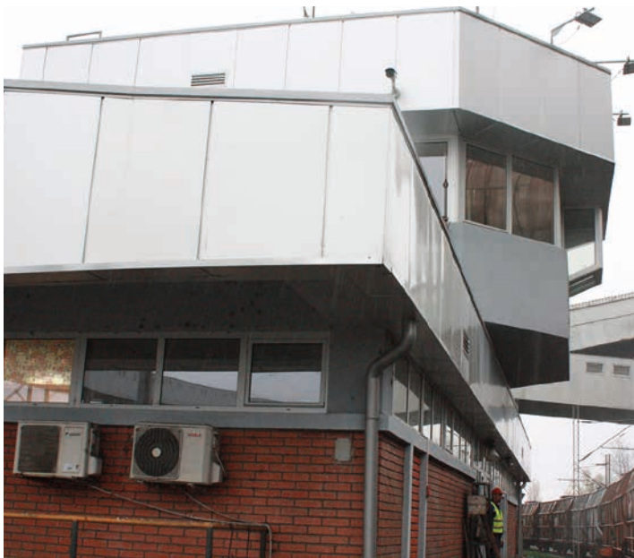
■ У Железничком транспорту ТЕНТ, почетком новембра завршена је реконструкција истоварне станице „Ворбис“, којом су створени знатно бољи услови за рад и боравак запослених, првенствено из Службе вуче и Саобраћајне службе. Замењени су дотрајали подови и столарија, преуређене су свлачионице, а нису изостали ни кречење и фарбање ентеријера. Уградњом нове ПВЦ столарије повећана је енергетска ефикасност објекта.
