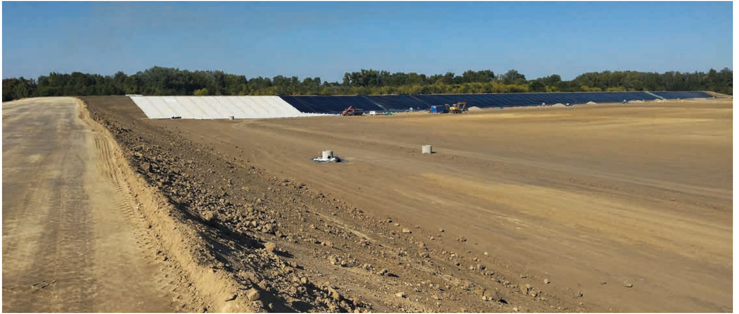
■ На депонији пепела и шљаке ТЕНТ А, 2021. године су започели радови на изградњи касете 4. Најважнији радови изведени су на централном делу касете, на изградњи иницијалног насипа, односно земљаног бедема који уоквирује касету, висине 6,5 метара и дужине три километра
