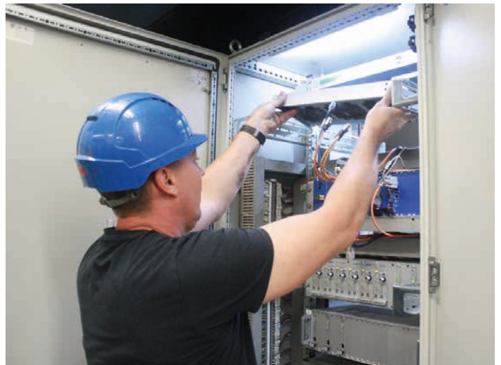
■ Постављање расхладних вентилатора у релејни орман
