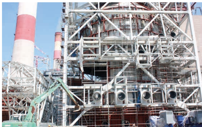
■ Уграђивање цевног система за апсорбер
