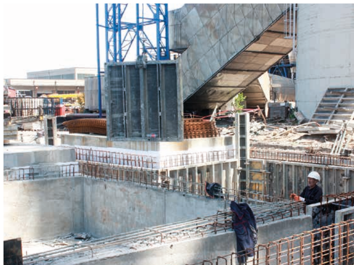
■ Постављање оплате за бетонске радове
