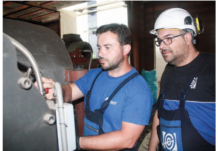
■ Провера параметара на регулационом вентилу
