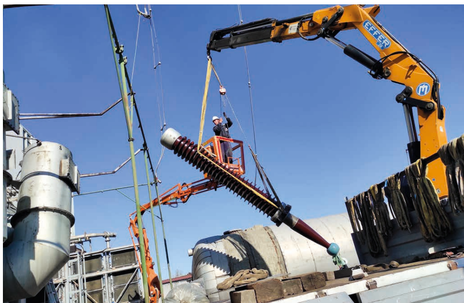
■ Демонтажа изолатора
