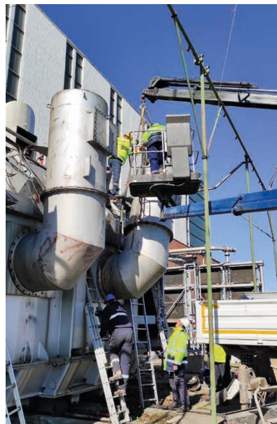
■ Радови на трансформатору
