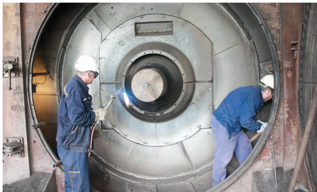
■ Радови на ремонту млинова
