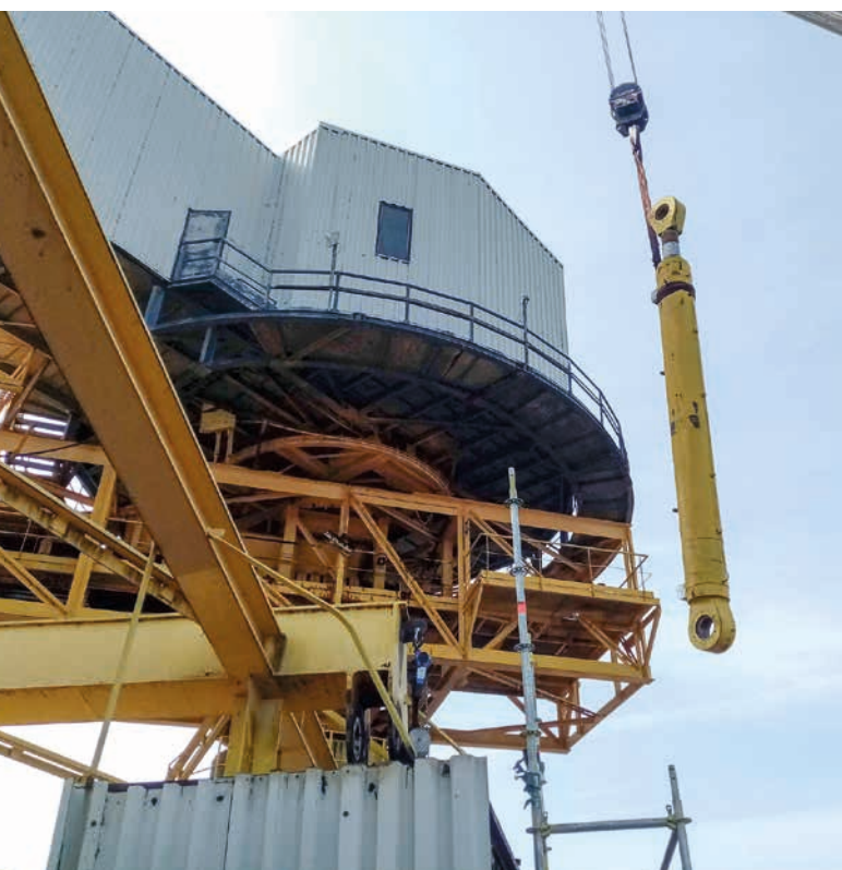
■ Замена другог цилиндра на копачу угља
