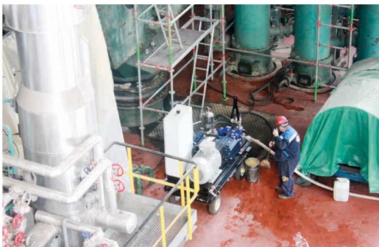
■ Припрема кондензатора за ремонт
