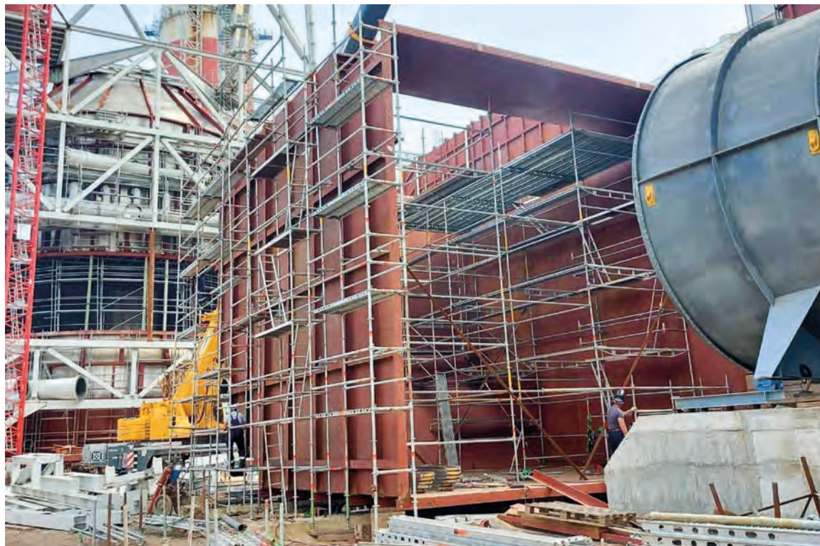
■ КДГ – монтажа челичне контструкције канала
