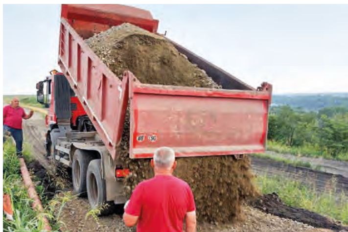
■ Касета 1 - насыпање завршног слоја
