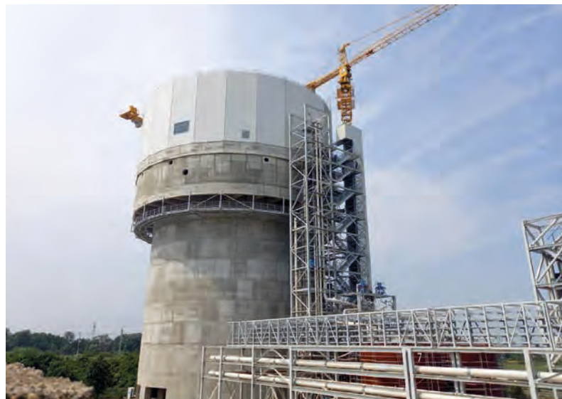
■ Силос гипса - монтажа цевовода и припрема за монтажу лифта
