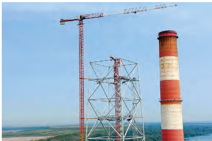
■ Апсорбер за блокове А3 и А4 – монтажа челичне конструкције влажног димњака
