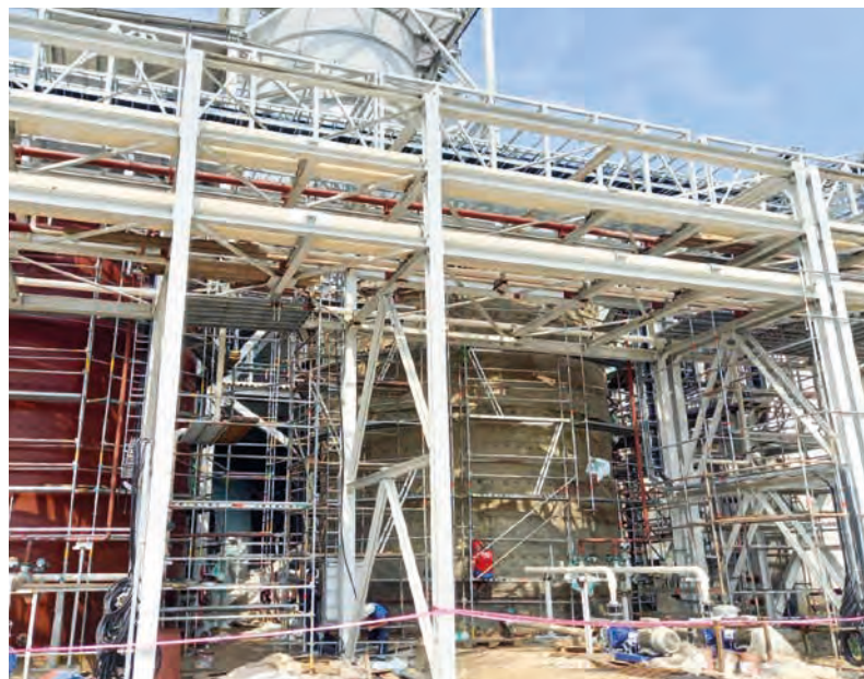
■ Резервоари хидромешавине - монтажа изолатије
