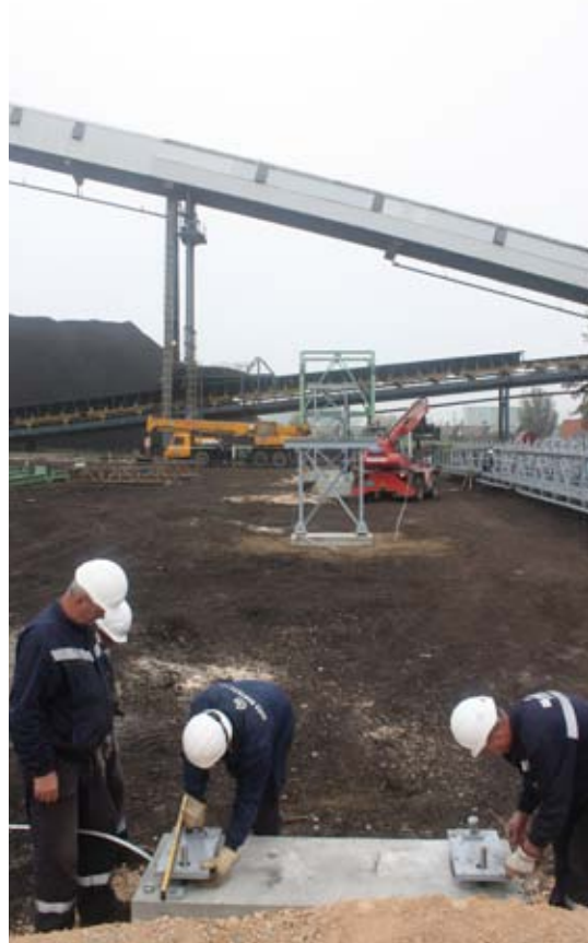
■ Радови на темељу за челичну конструкцију
