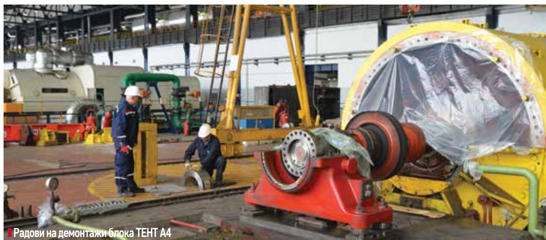
Демонтажа турбине
