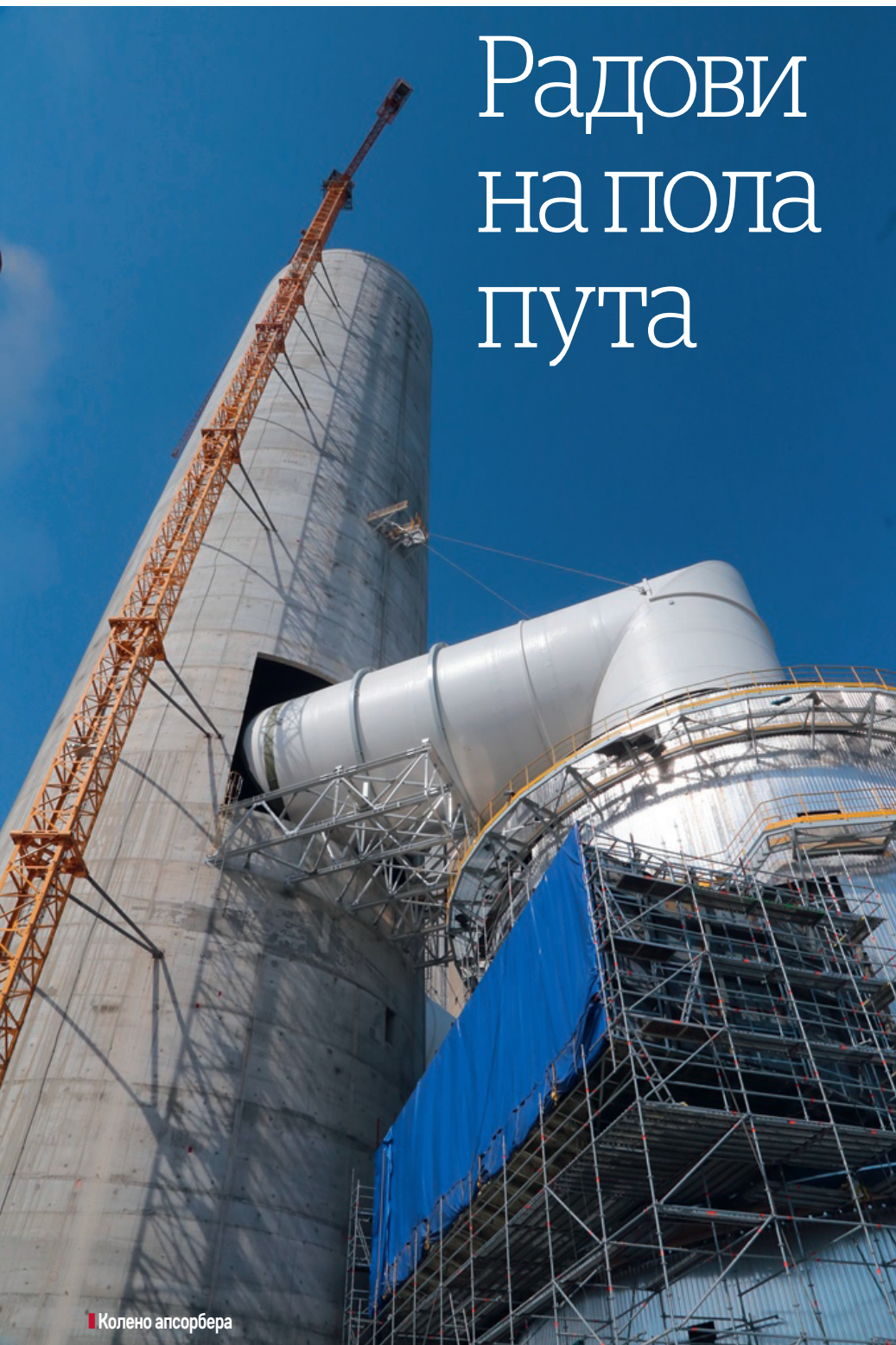
■ Демонтажа цевног система котла
