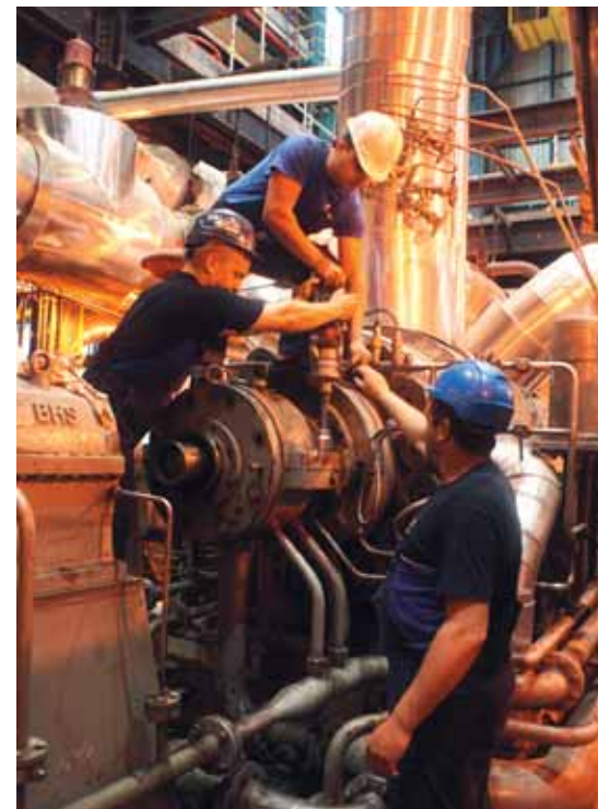
■ Радови на вентилу мале турбине током капиталног ремонта блока Б1
