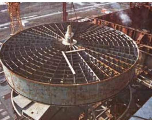
■ Уграђивање ротационог загрејача ваздуха приликом градње ТЕНТ Б
