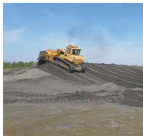
■ Изградња насипа на касети 2
