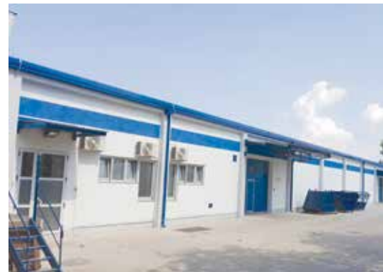
■ Завршена изградња складишта уља и мазива на ТЕНТ А
