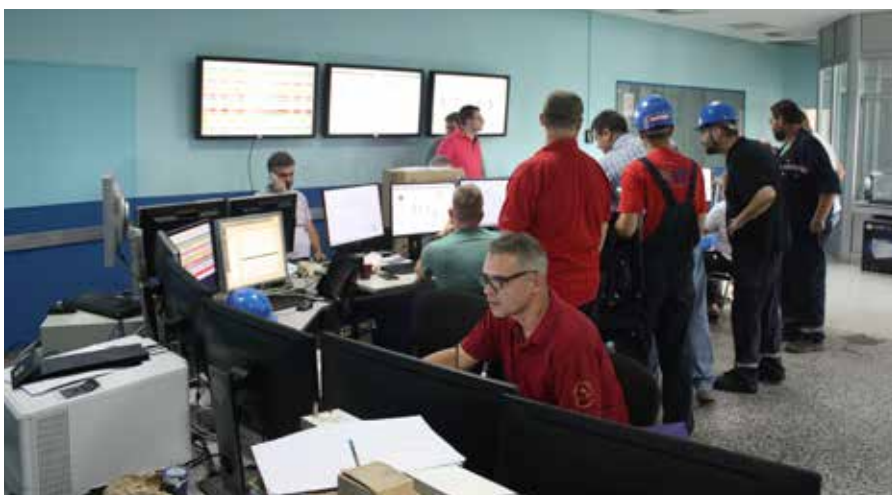
■ Хладна проба котла
