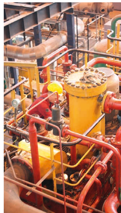
■ Систем за подмазивање турбине
