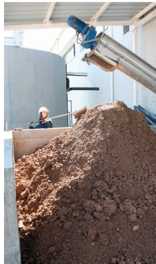
■ Складиштење муља из постројења С3
