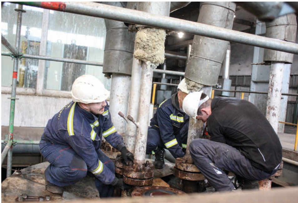
■ Ремонт блока 5 у ТЕ „Колубара“
