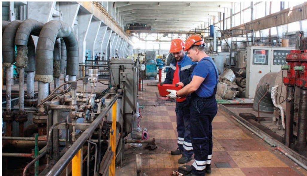
■ На ремонтима ангажован велики број радника
